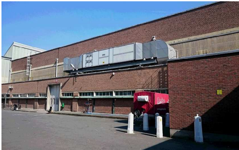
レンガ壁の外壁
